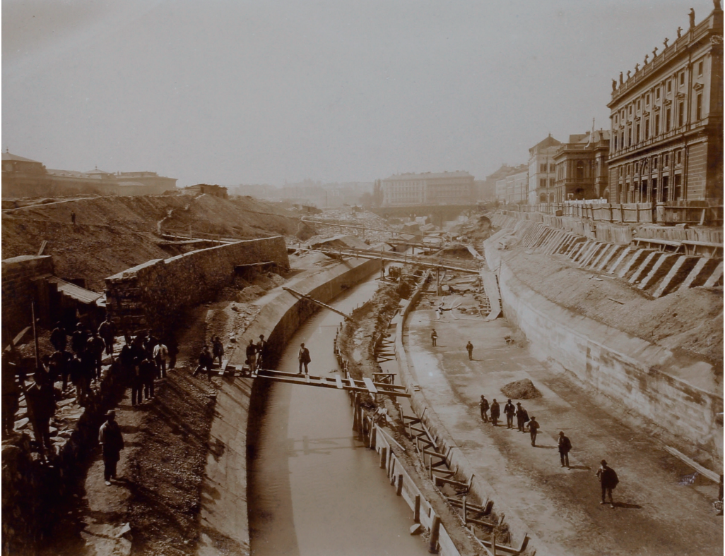
03-23: Stand der Arbeiten 1898, Bauarbeiten entlang der Lothringerstraße, rechts im Bild der Musikverein und das Künstlerhaus, Aufnahme Aron Feuerzeug, EA-002567-02
