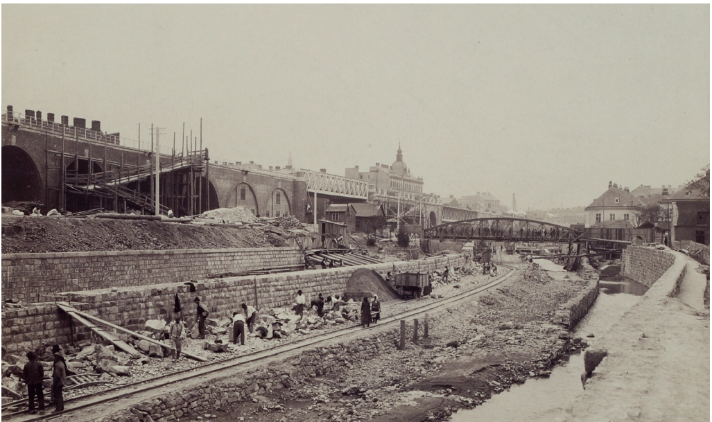
03-18: Baufortschritt zwischen Gaswerk und Stiegerbrücke, Aufnahme April 1898, EA-002557-03
