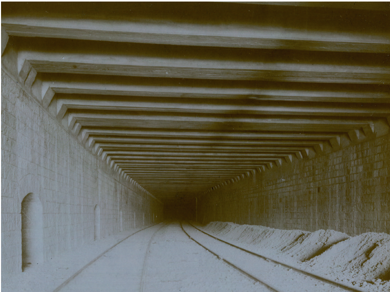
03-20: Innenansicht Fahrbahnüberdeckung Station Margaretengürtel, Hersteller: Wayss & Co, Aufnahme 1898, EA-002578-01
