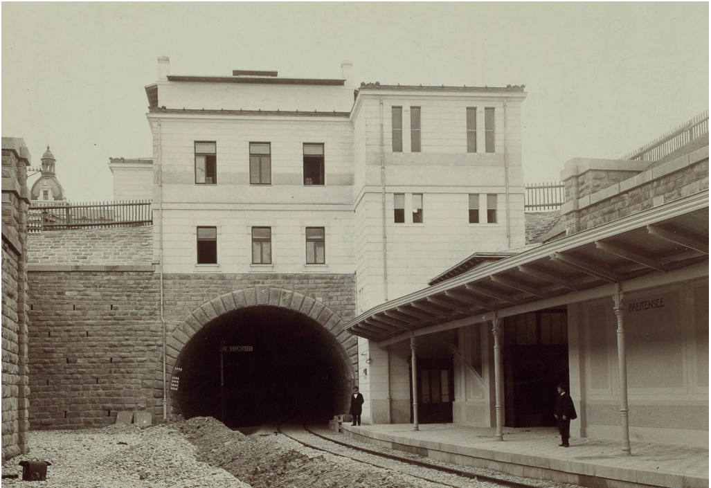
03-05: Eingleisiger Betrieb: Station Breitensee mit Südportal des Schmelzer Tunnels, Mai 1898, Aufnahme R. Lechner (Wilh. Müller), EA-002557-07
