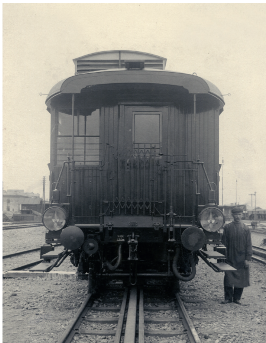
05-07: Motorwagen während der Versuchsanordnung von Siemens & Halske, Stirnansicht CDu Motorwagen, elektrischer Probebetrieb – Wiener Stadtbahn, Aufnahme 1901–1903, EA-002554-15
