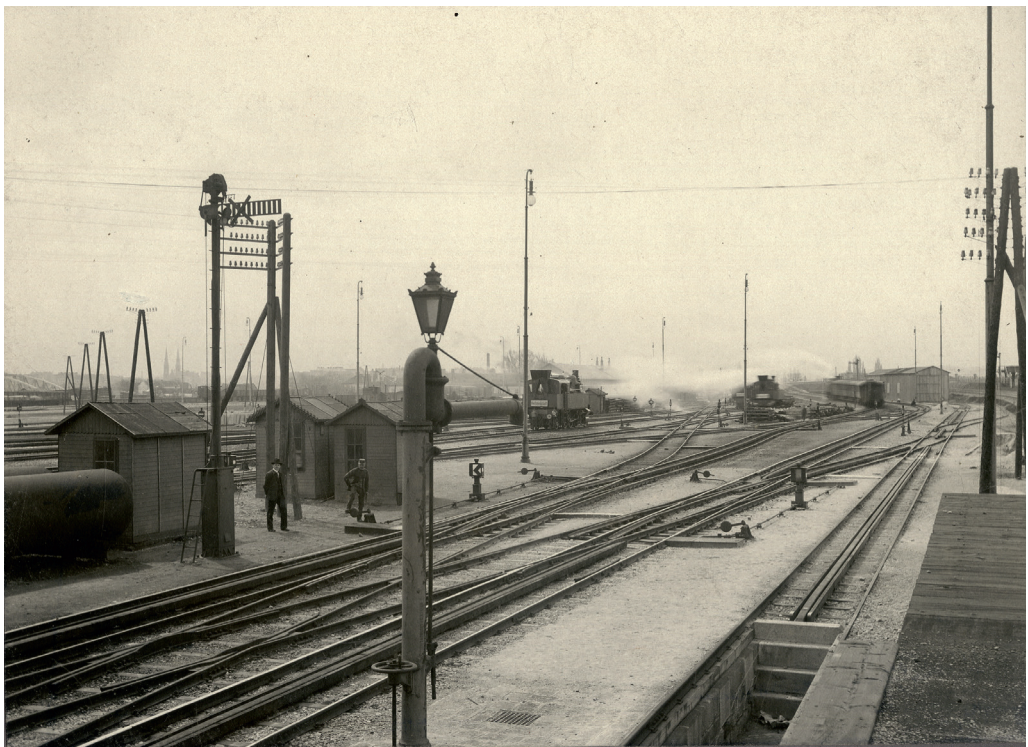
04-17: Gleisanlage im Bahnhof Heiligenstadt, ausgerüstet mit Stromschienen für den elektrischen Probetrieb, Aufnahme 1901–1903, EA-002554-04
