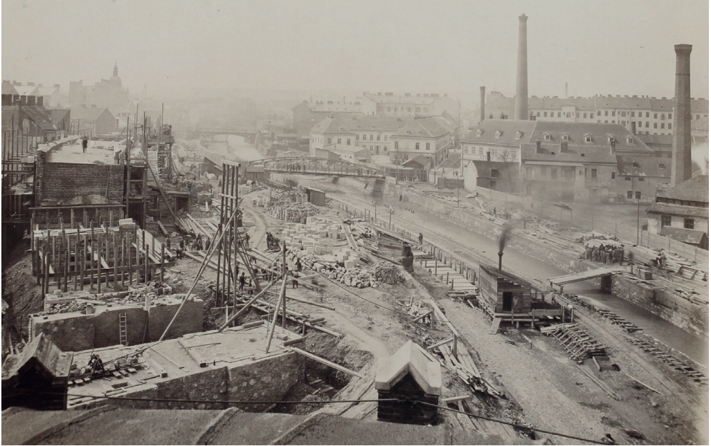
03-17: Bauarbeiten beim ehemaligen Gaswerk, Stiegerbrücke bis zum Storchensteg (heute Gaudenzdorfer Gürtel bis U-Bahnstation Längenfeldgasse), Frühjahr 1896, Fotobestand Albert Stächelin, EA-002530-02
