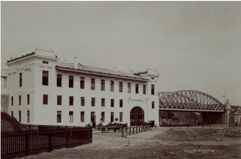
03-04: Station Hernalis mit schräg gestellter Gitterbrücke, Mai 1898, Aufnahme R. Lechner (Wilh. Müller), EA-002557-06
