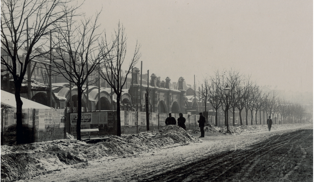
03-08: Der in die Gürtelbögen bereits integrierte Probeviadukt auf Höhe Michaelerstraße, zwischen Nussdorfer und Währinger Straße, Aufnahme Jänner 1896, EA-002580-11
