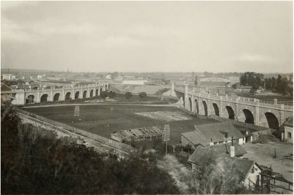
03-02: Detail der fertigen Viaduktbogenstrecke der Vororte- und der Gürtellinie vor Heiligenstadt, Frühjahr 1898, Aufnahme Hans Pabst, EA-002571-18
