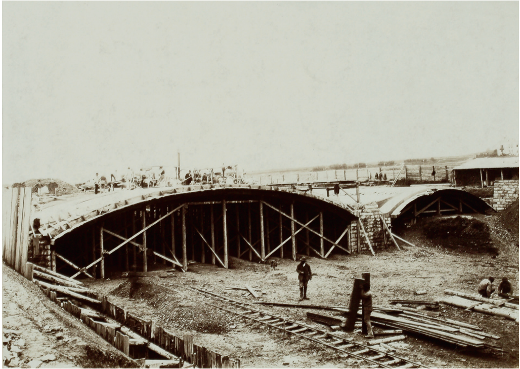
03-06: Überbrückung der Kreuzgasse. Herstellung der Gewölbeplatten; Pfeiler und Auflager aus Bruchsteinmauerwerk, seitl. Errichtung der Futtermauern, Aufnahme 1898, EA-002569-02
