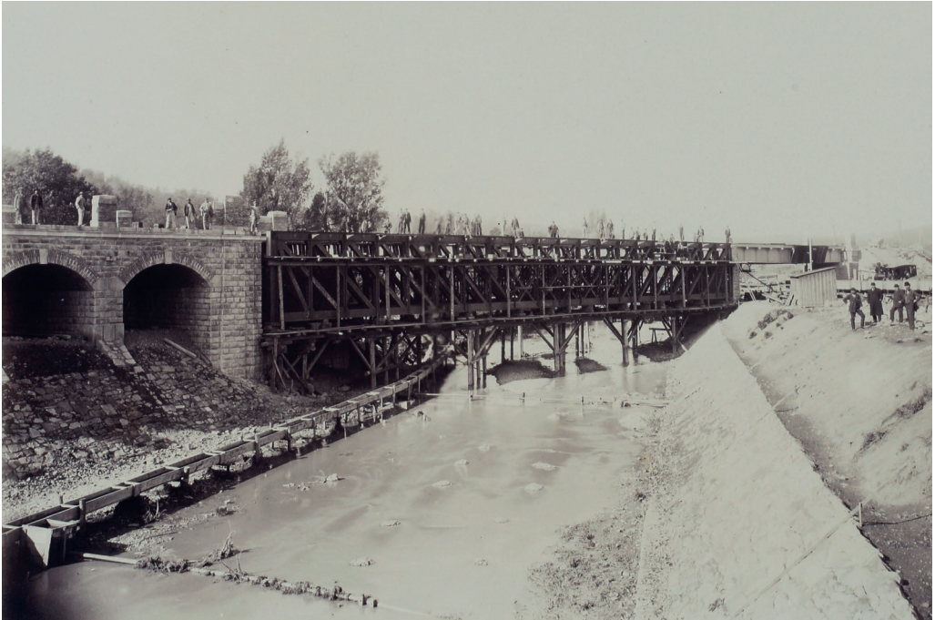
03-14: Stadtbahnbrücke bei Hütteldorf-Hacking über den Wienfluss, 1894–97, Aufnahme Wilhelm Steidel, EA-002592
