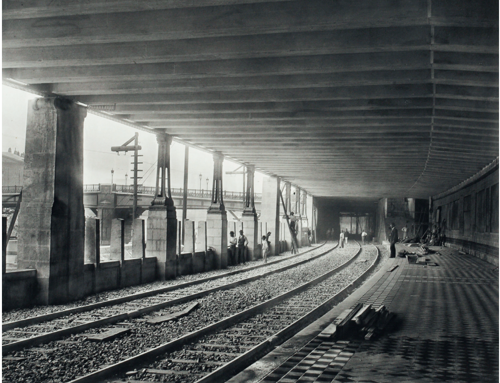
03-27: Haltestelle Ferdinandsbrücke: der bereits errichtete Bahnsteig mit Massivbalkendecke, Hersteller: Union-Baugesellschaft, Mai 1901, Aufnahme Carl Bosnjak, EA-002553-03
