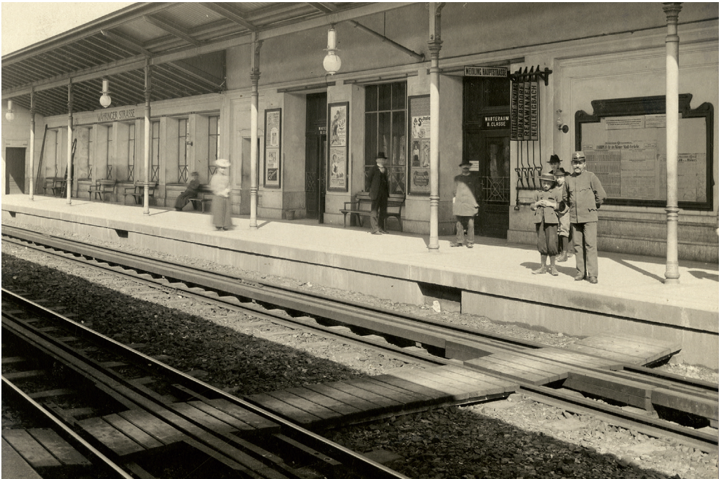
04-18: Haltestelle Währinger Straße mit Stromschielen für den elektrischen Probetrieb, Aufnahme 1901–1903, EA-002554-10
