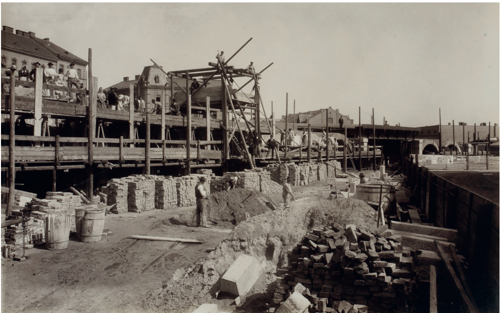
03-09: Baufortschritt Gürtellinie in Währing; Aufmauern der Bögen, 1896/97, Aufnahme Wilhelm Steidel, EA-002605
