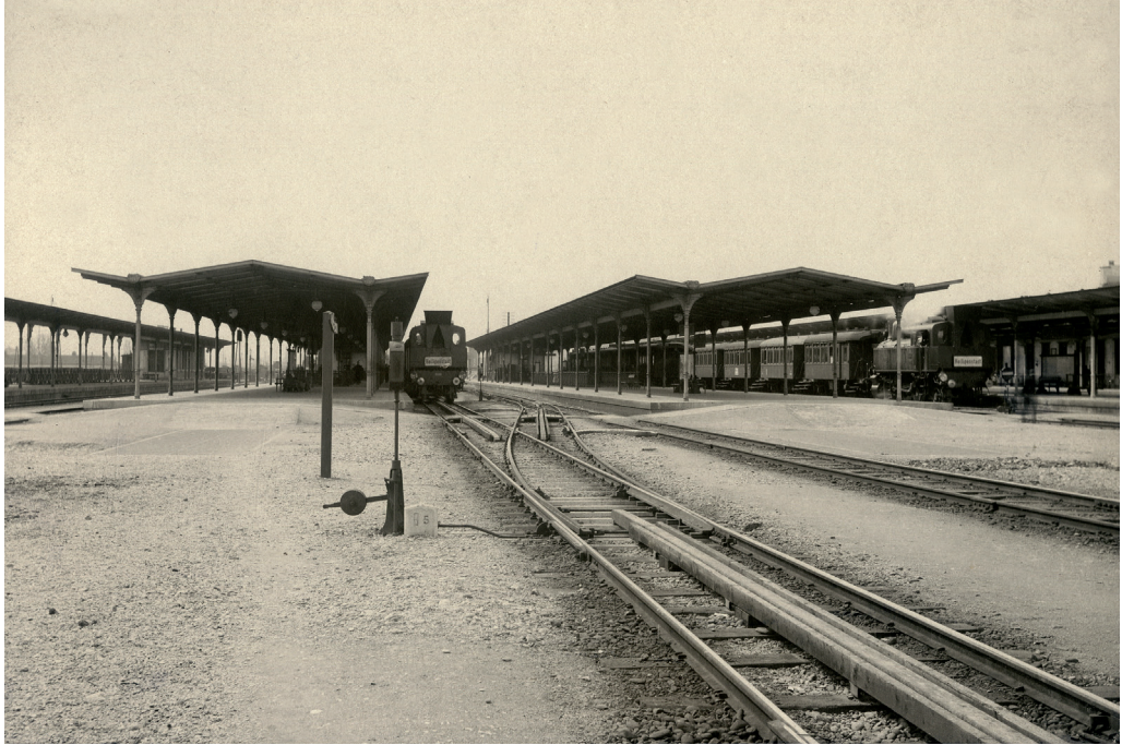
03-01: Die Weitläufigkeit der groß angelegten Bahnanlage Heiligenstadt mit den Bahnsteigen, Aufnahme 1901–1903, EA-002554-07
