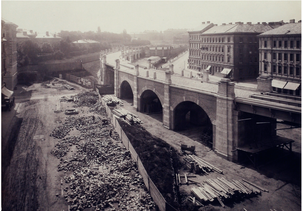
03-10: Die Gürtelbögen am Währinger Gürtel, 1897, Fotobestand Albert Stächelin, EA-002512
