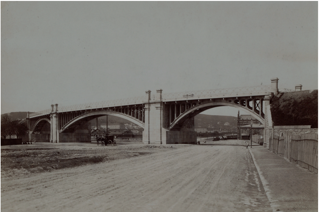
02-01: Dreibogige Brücke über die Richthausenstraße bei Hernals, Mai 1898, Aufnahme R. Lechner (Wilh. Müller), EA-002557-05
