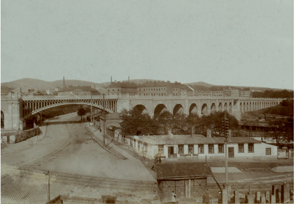
03-07: Viaduktstrecke von der ehemaligen Nussdorfer Linie bis Heiligenstadt; Bogenbrücke über die Döblinger Hauptstraße, neun Viaduktbögen bis zur Durchfahrt Rosinagasse (heute Glatzgasse) und 25 Viaduktbögen bis zur Bogenbrücke Heiligenstädter Straße, Frühjahr 1898, Aufnahme Hans Pabst, EA-002571-14
