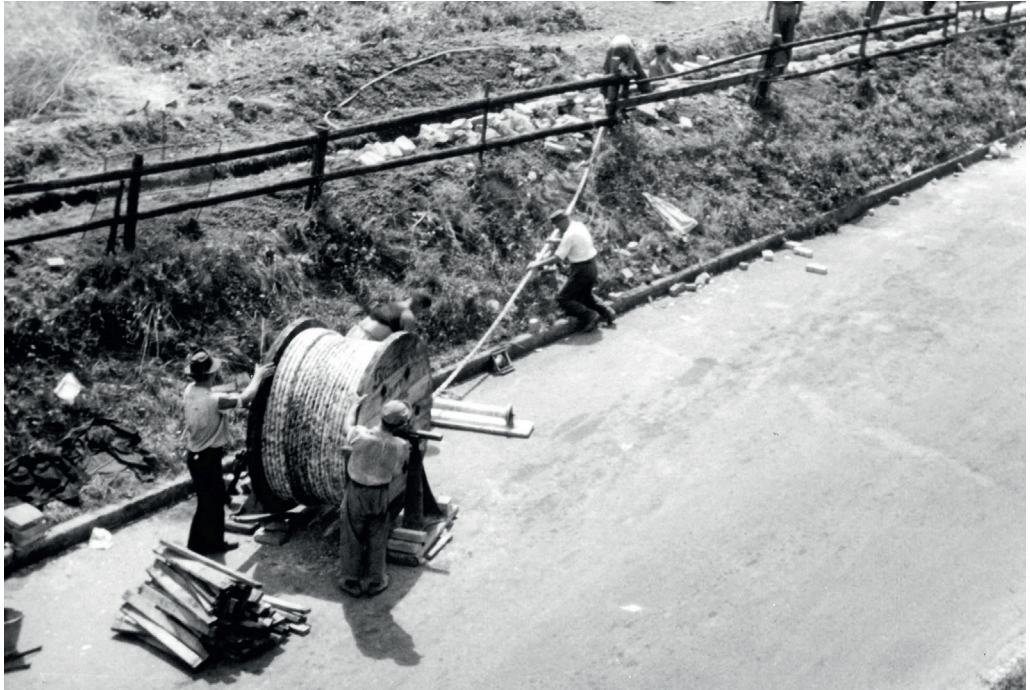
66 Legung eines Koaxialkabels in Tirol.
