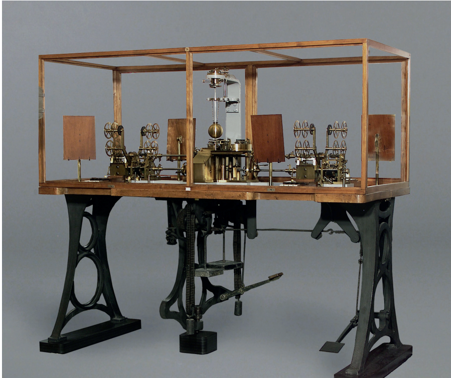
28 Ausnutzung der Leitungskapazität durch den Vierfachtelegraphen von Meyer.
